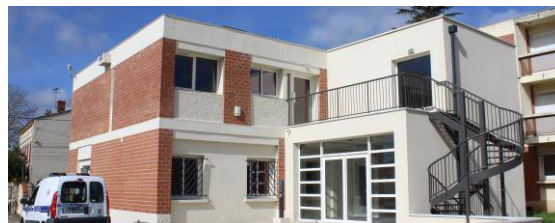
Rénovation Ancienne Gendarmerie
